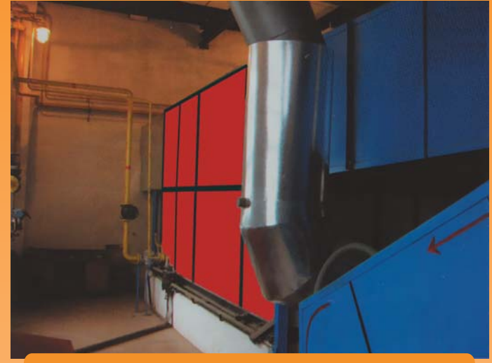
Криворожский железорудный комбинат. Система отопления ствола шахты «Родина» КЖРК, АГОР-2500.
