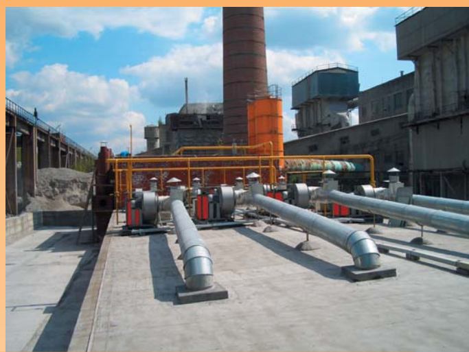
ООО «Гипсобетон», Московская область, г. Видное. Сушка гипсовых пазогребенных плит, АГОС-4, 8шт.
