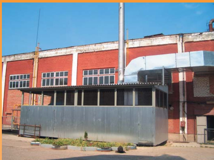
«Экспериментальный завод ДСП», Московская область, г. Сергиев Посад. Отопление и вентиляция производственных помещений, воздухонагреватель АГОР-2500. Аппарат установлен на улице.
