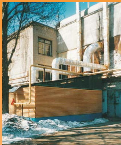
ОАО «Ступинский завод стеклопластиков». Воздушное отопление категорийных цехов взамен водогрейного от ТЭЦ. Подсоединено к уже существующей системе вентиляции. Аппараты установлены на улице. АГОР-800 – 2шт
