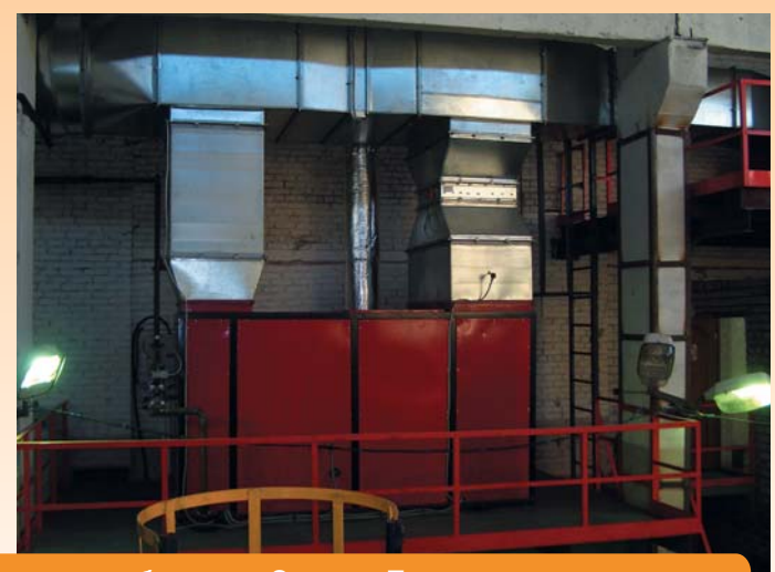
«Экспериментальный завод ДСП», Московская область, г. Сергиев Посад. Отопление производственных помещений, воздухонагреватель АГОР-800 с вентилятором двухстороннего всасывания производительностью 50 тыс м 3 /час. на восполнение воздуха, забираемого на технологические нужды
