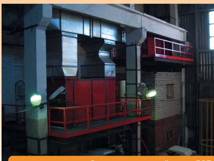
«Экспериментальный завод ДСП», Московская область, г. Сергиев Посад. Отопление производственных помещений, воздухонагреватель АГОР-800 с вентилятором двухстороннего всасывания производительностью 50 тыс м 3 /час. на восполнение воздуха, забираемого на технологические нужды
