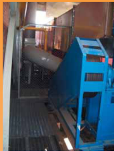
«Экспериментальный завод ДСП», Московская область, г. Сергиев Посад. Отопление и вентиляция производственных помещений, воздухонагреватель АГОР-2500. Аппарат установлен на улице.
