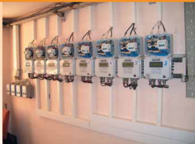
ООО «Гипсобетон», Московская область, г. Видное. Сушка гипсовых пазогребневых плит, АГОС-4, 8шт.
