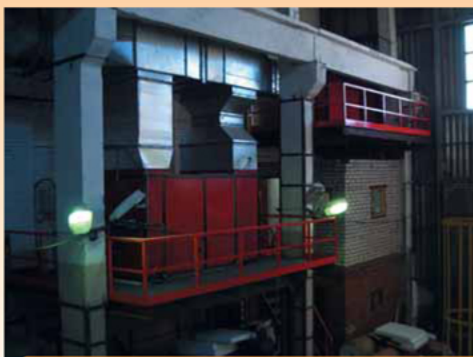
«Экспериментальный завод ДСП», Московская область, г. Сергиев Посад. Отопление производственных помещений, воздухонагреватель АГОР-800 с вентилятором двухстороннего всасывания производительностью 50 тыс м 3 /час.
