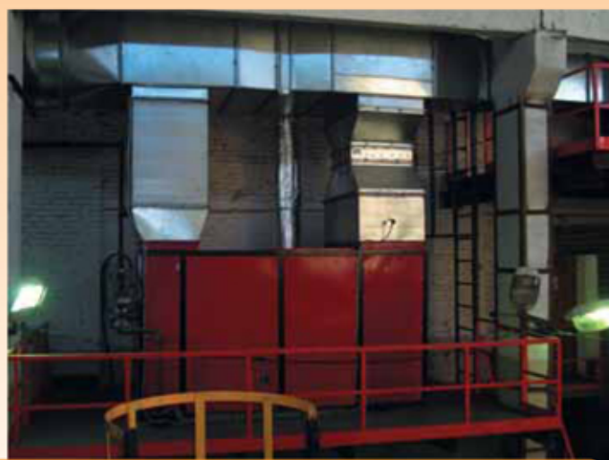
«Экспериментальный завод ДСП», Московская область, г. Сергиев Посад. Отопление производственных помещений, воздухонагреватель АГОР-800 с вентилятором двухстороннего всасывания производительностью 50 тыс м 3 /час.
